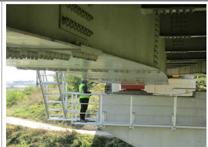
▲ 교량받침 점검로 근접조사
