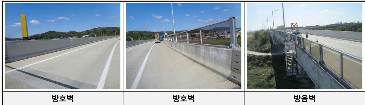
[방호벽 및 방음벽 전경]
